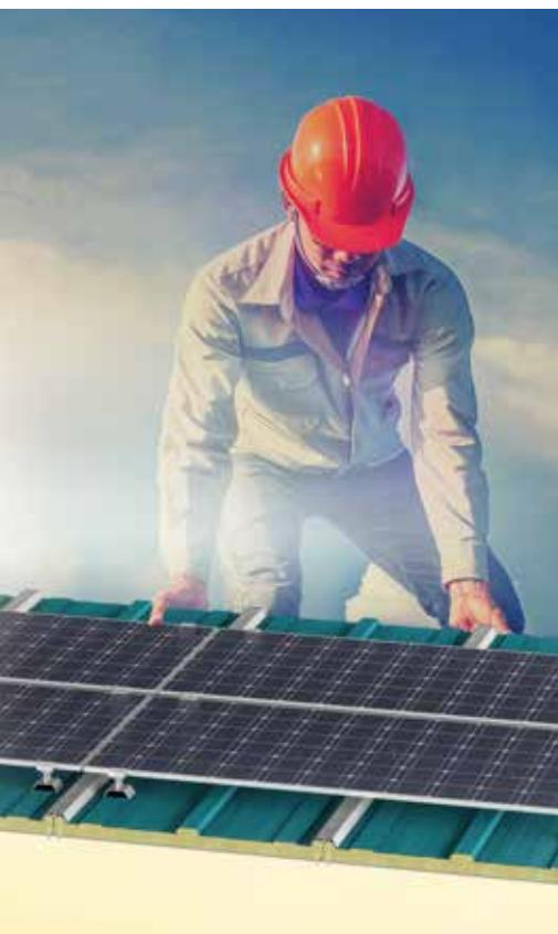
**Solar Kepli Panel**'in özel kelepçe sistemi ile güneş panelleri sandviç panel yüzeyi delinmeksizin direkt olarak monte edilebiliyor. Bu sayede yapılarda vida deliklerinden kaynaklı korozyon ve su yalıtımı riskleri ortadan kaldırılarak çatıların yapısal bütünlüğü korunuyor ve **yapı ömrü uzatılıyor**. Üstelik düşük eğimde montaj imkânı sunan tasarımlıyla çelik konstrüksiyonda **maliyet avantajı sağlıyor**.
